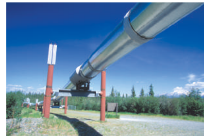
شېۋە 9-10 ھېلېكى بۇرى نەوتى بەكاڭدە پارىزراو، بەھۇي كېلېكى تەرىبى زىنكەو.
